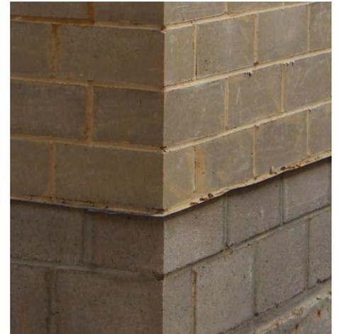
Membrane d'étanchéité entre maçonnerie béton et Blocs Compressés de Léém
