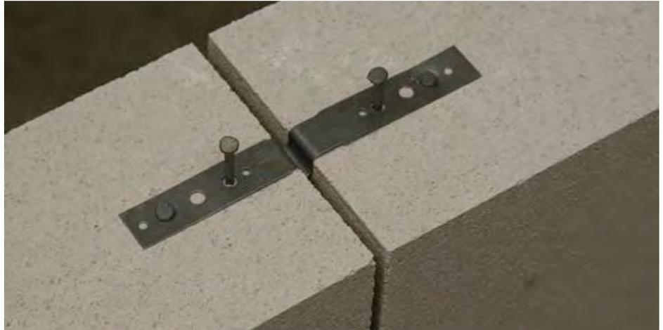
Exemple d'ancrage de dilatation dans une maçonnerie en béton cellulaire [6] p.105
